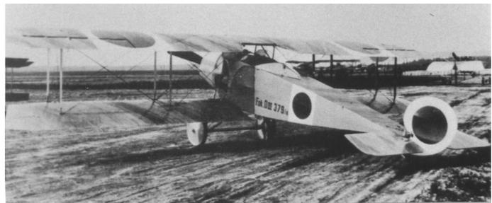
Sie basierte auf der Modifikation der M.17Z (D.II). Anstelle des dort verwendeten 100 PS Oberursel Umlaufmotors wurde hier der 160 PS liefernde, doppelreihige Oberursel »U III« verwendet. Die Motoraufnahme und zahlreiche Rumpfdetails entsprachen der E.IV, sogar das Design der Motorhaube wurde übernommen.
