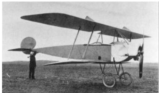
Da die M.10 direkt aus der M.7 hervorging, ist auch ihr Aufbau mit dem der M.7 weitgehend identisch. Als Verbesserung war die Konstruktion der M.10-Tragflügel gegenüber der Ausführung bei der M.7 verstärkt worden. Zusätzlich erhielt der vordere Spannturm, an welchem der Vorderholm des Oberflügels abgebracht war, zwei weitere stützende Stahlrohrstreben, die jeweils links und rechts an den vordersten Rumpfspant führten. Im Führerstand des Beobachters wurde ein Funkgerät installiert.
