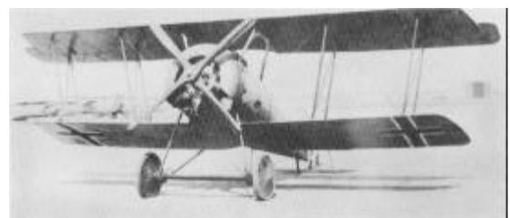
Die Pfalz D.VIII wurde in einer kleinen Stückzahl gefertigt. Die Serienmaschinen erhielten allerdings den »Sh III« und so blieb es nur bei einem dieser Flugzeuge mit dem Oberursel 145 PS 11-Zylinder.
