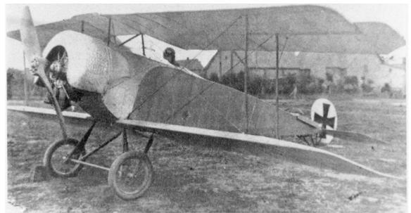
Das Fahrwerk war identisch mit dem der D.II und besaß ebenfalls die zwei Vorderstreben. Beim Prototyp waren diese verkleidet.
