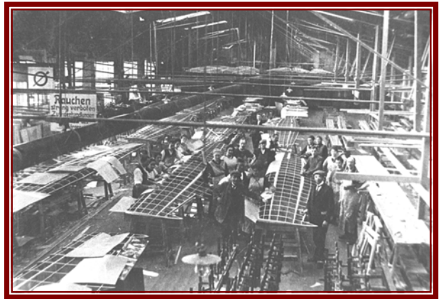
289. Wie einfach der Serienbau der Flügel auf Böcken ausgeführt werden konnte wird in dieser Aufnahme deutlich.
