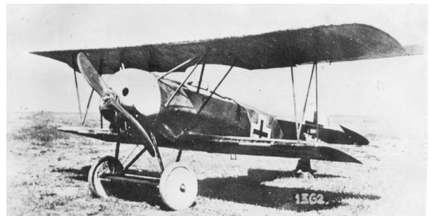
Die Konstruktion der V.9 basierte stark auf der des Dr.I. Der Rumpf war sogar weitgehend der gleiche. Nicht einmal die Aufnahme des Unterflügels wurde abgeändert. Auch das Rumpfheck und das Leitwerk wurden beibehalten.
