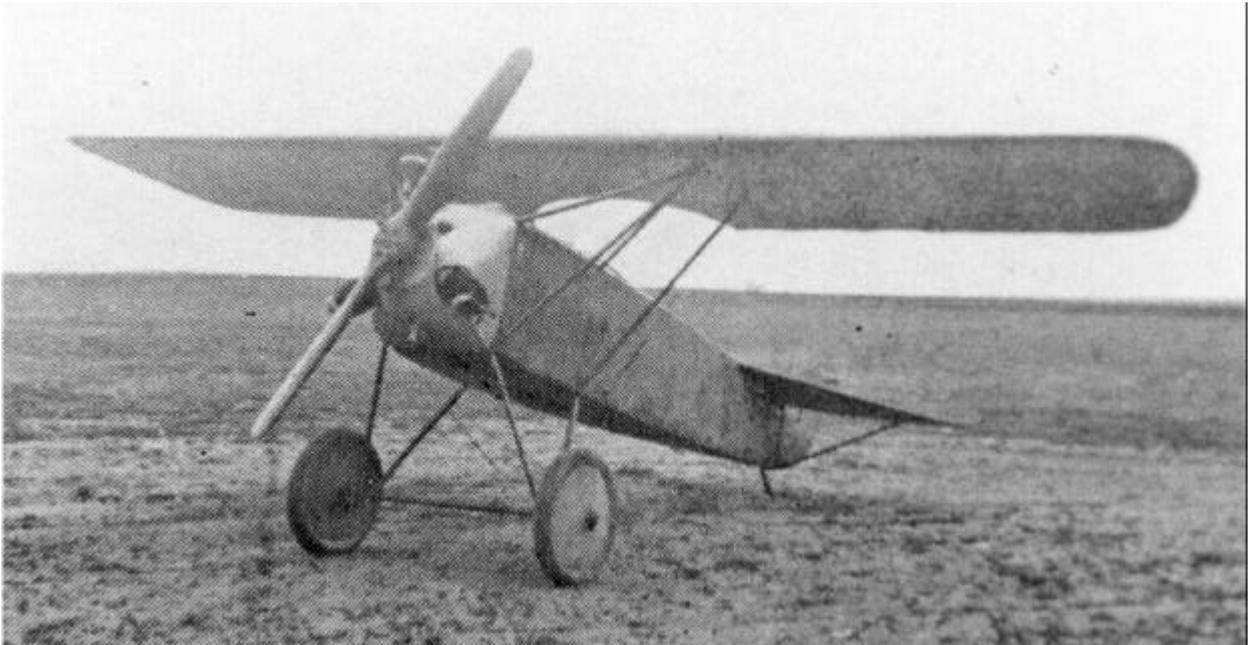
Das Fahrwerk war auch bei ihr sehr einfach aufgebaut. Um die Kosten der Käufer möglichst gering zu halten besaß die V.40 zunächst keine richtigen Felgenreäder mit Reifen, sondern Holzräder die mit Stoff bespannt wurden. Später wurden diese durch richtige Räder ersetzt, da man merkte, dass die Starts und Landungen ohne sie doch recht unsanft ausfielen.
