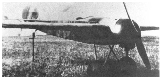
Der Tragflügel der V.17 war wie der der V.1 komplett mit 1,5mm Birkenperrholz beplankt. Die Querruder waren in den Flügel eingelassen und besaßen keinen aerodynamischen Ausgleich.
